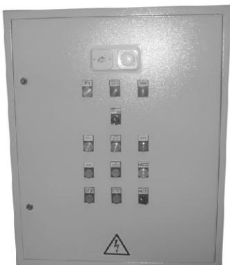
Регулировка температуры приточного воздуха при помощи терморегулятора Klimat 101. Терморегулятор управляет работой электропривода двух- или трехходового регулирующего вентиля, который меняет подачу горячей воды в водяной калорифер. Защиту от замерзания водяного калорифера осуществляет как сам терморегулятор, так и термостат защиты по воздуху TF. Циркуляционный насос повышает давление в системе и уменьшает риск замерзания воды.
